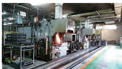
本社工場・熱処理設備
