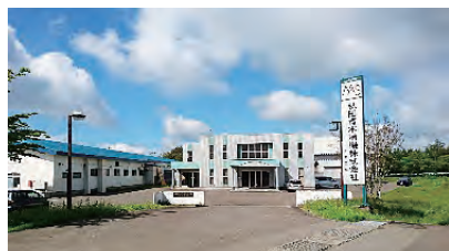
本社工場・事務所
